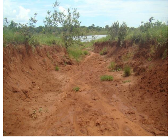
Foto - 8. Detalhe da parte interior do processo erosivo PE1 na sua parte intermediária.
