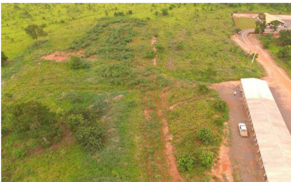
Figura 12. Imagem aérea da área do antigo bloco dos alojamentos operacionais e acesso. 1ª Imagem: outubro/2019; 2ª Imagem: janeiro/2020. Fonte: Fibracon, janeiro de 2020.
