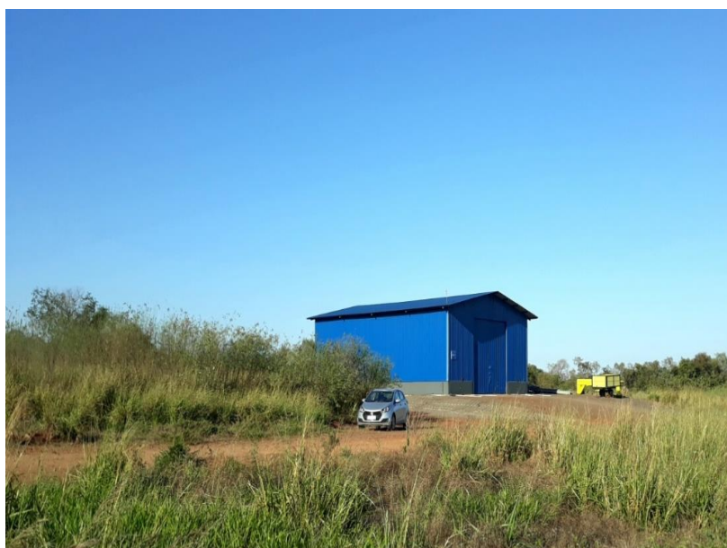
Figura 21. Imagem térrea da área próxima ao almoxarifado e britado mostra que ainda há falhas na cobertura do solo por vegetação. PRADE - PCH Verde 4A, junho de 2020.
