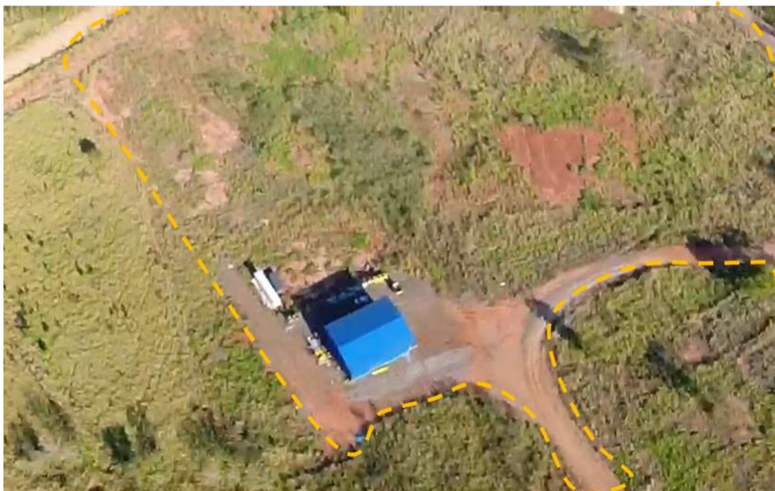
Figura 20. Imagem aérea da área próxima ao almoxarifado e britado mostra que ainda há falhas na cobertura do solo por vegetação (indicação traço). PRADE - PCH Verde 4A, junho de 2020.
