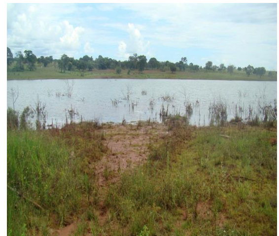
Foto - 10. Detalhe atual do final da voçoroca com evidência de recuperação natural em andamento.
