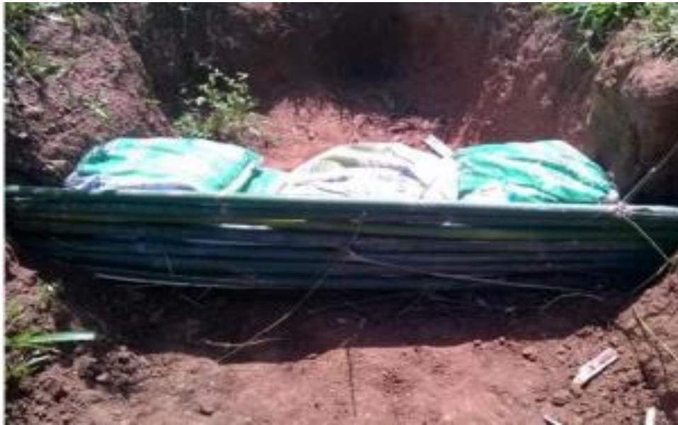
Figura 5 – Exemplo de utilização de paliçada de bambu com sacos de rafia contendo terra.
